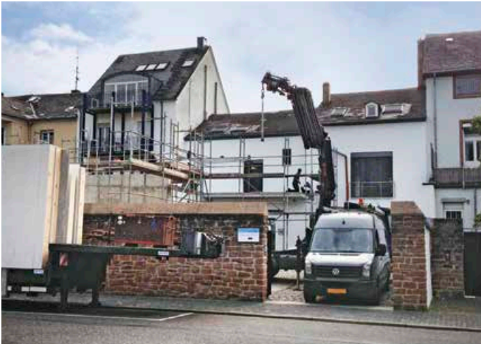
▲ Nur eine Woche dauerte das Aufstellen des Baukörpers
