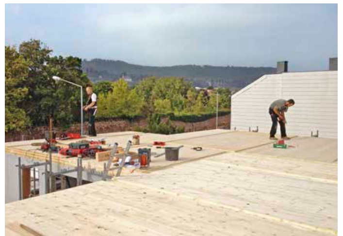
▲ Die Flachdachdecke der neuen Wohneinheiten für Studenten besteht aus Brettsperholz
