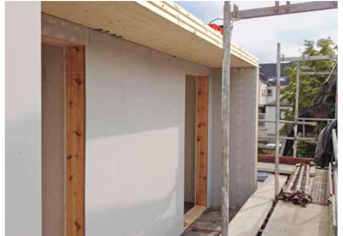
▲ Ein kleines Vordach vor der Eingangstür dient als Witterungsschutz
