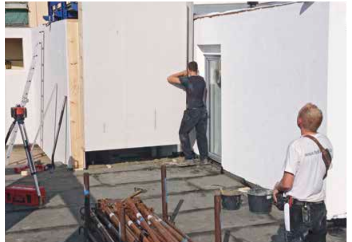
▲ Die Aufstockung führten die Handwerker in Form von gekapselten Außenwänden aus
